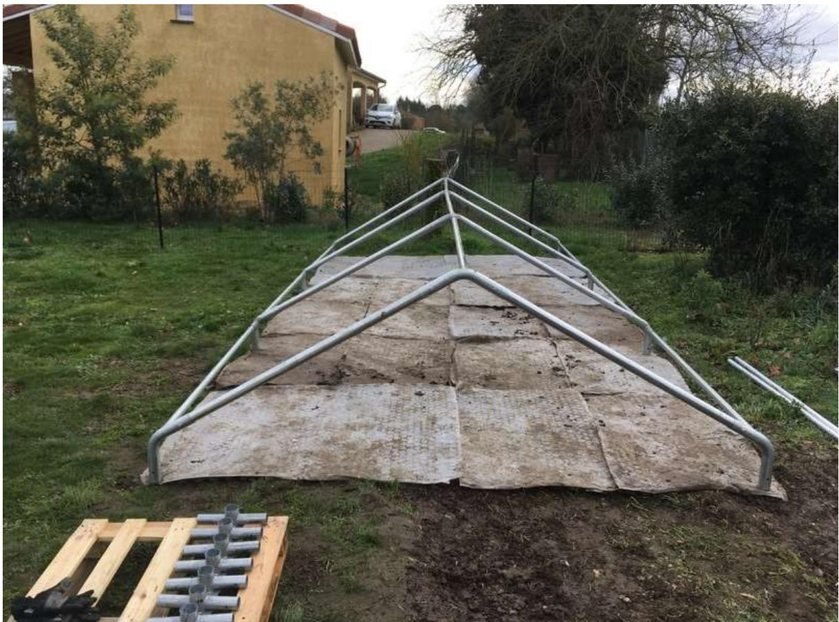
Début assemblage (une clé de 14, un tournevis cruciforme).
