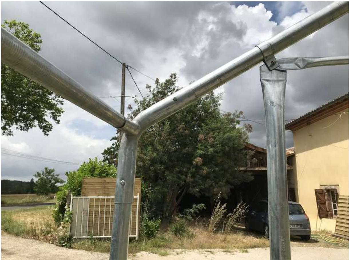
Détail de la fixation des deux montants droits côté accès.
