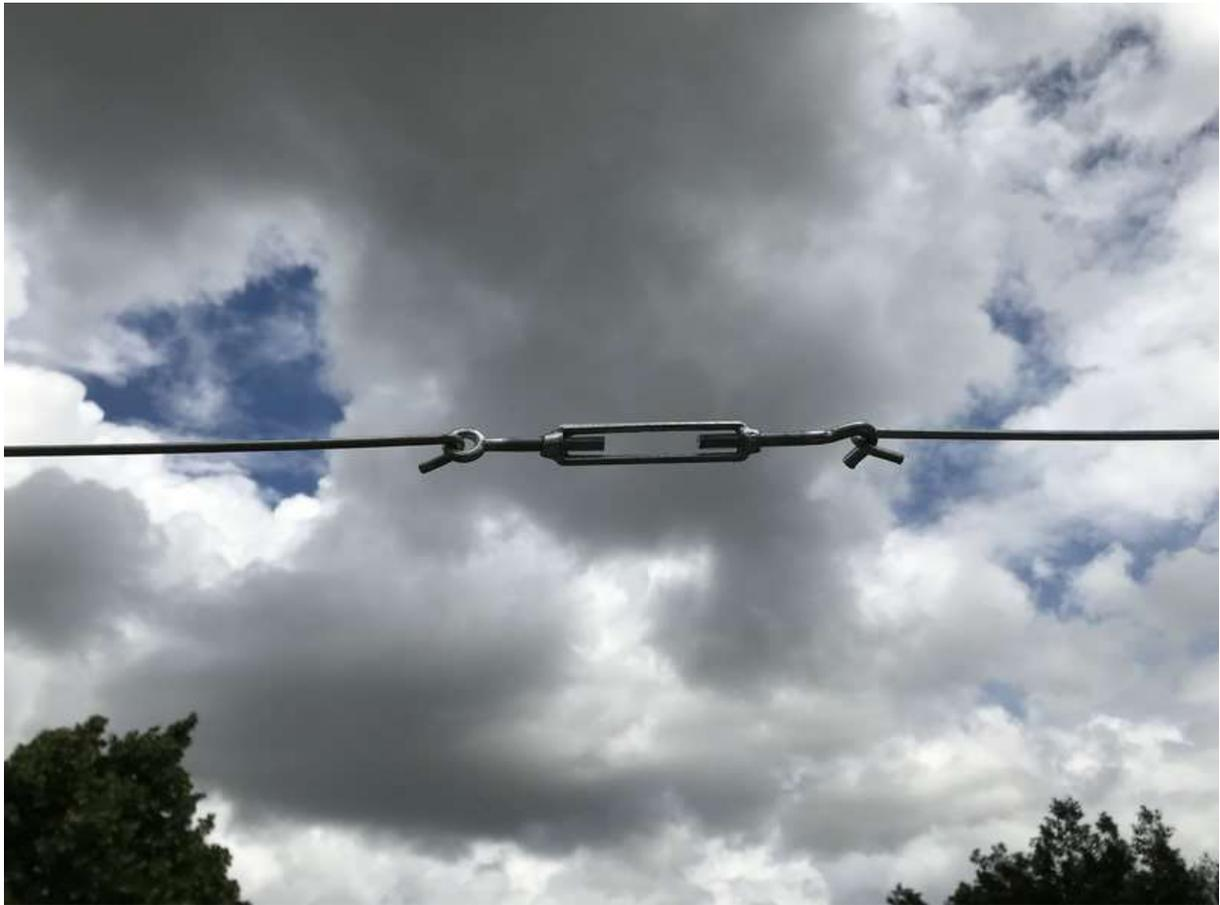
Tendeurs à poser crochets vers le bas sinon on déchirera la couverture.
