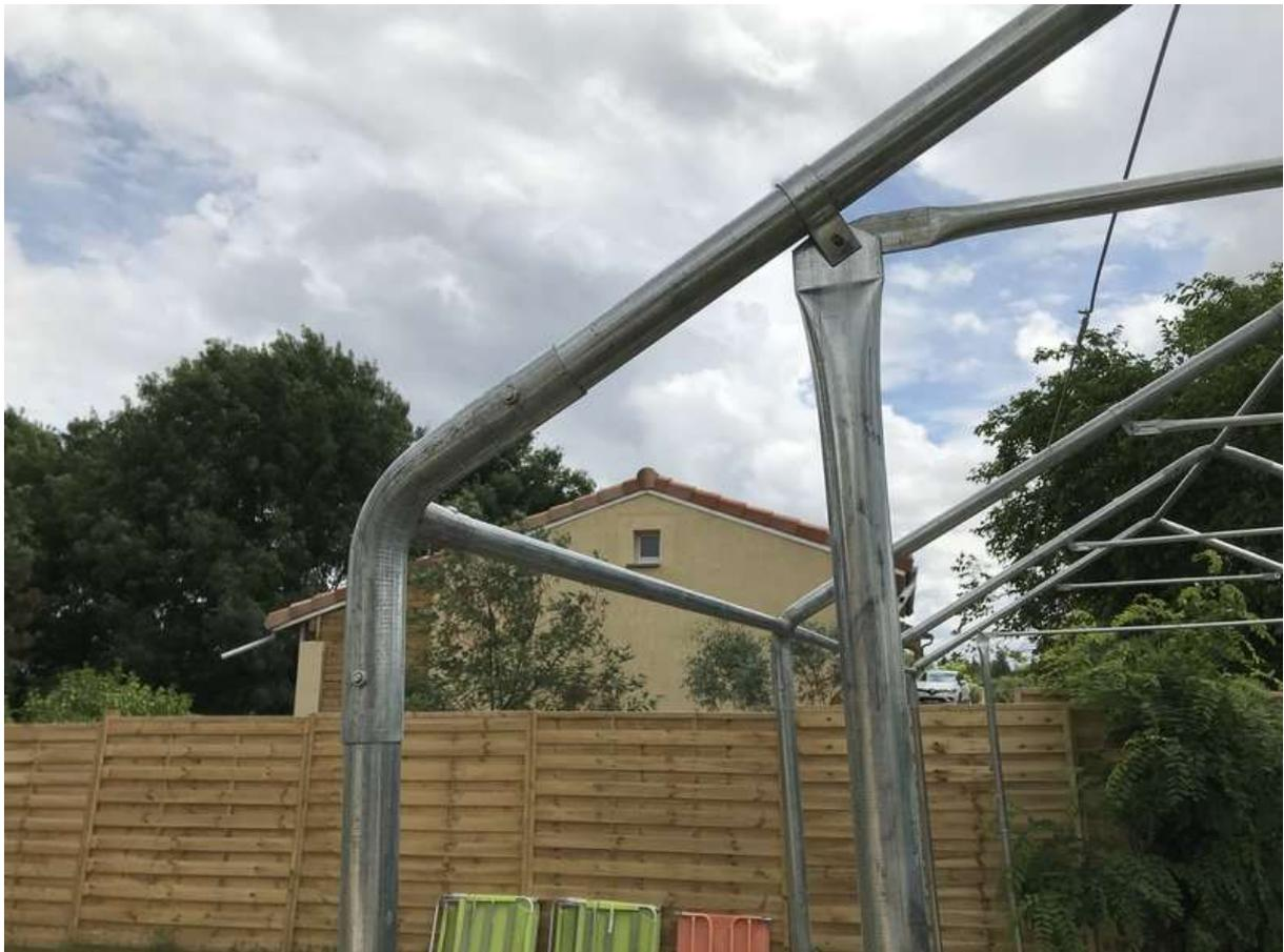
Détail de la fixation des deux montants gauches côté accès.
