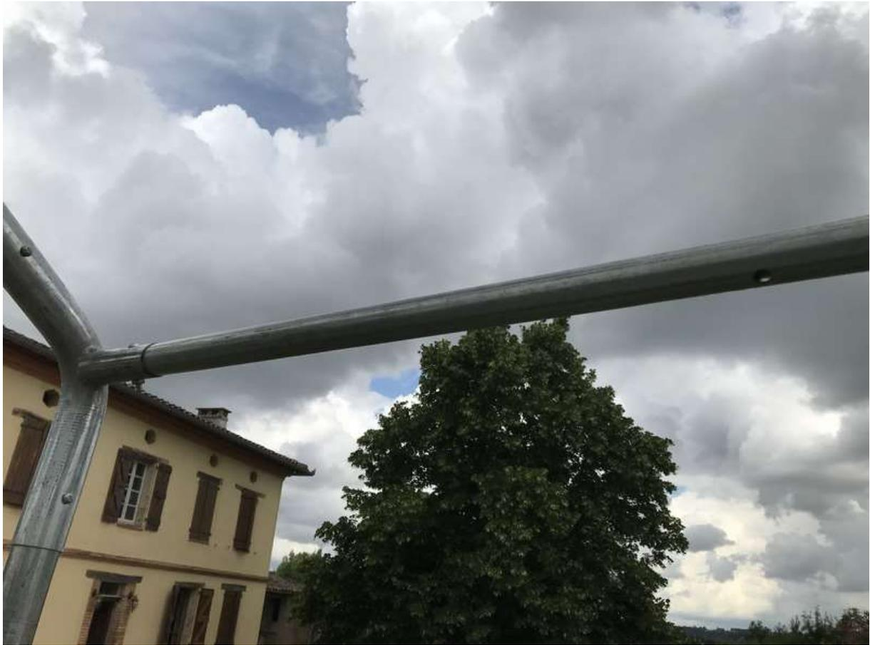
Le bug qui tue. Ces quatre tubes comportent un trou (à droite sur la photo) destiné à fixer les contrevents. Vu que la pose des contrevents n'était pas documentée dans la doc (perdue), les tubes ont été montés incidemment dans le mauvais sens, donc l'emplacement des trous ne permettait plus la fixation des contrevents vu que les trous ne sont pas centrés sur les tubes (et tout démonter pour quatre contrevents...)
