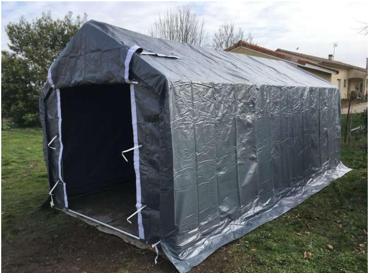
La couverture avant sa fixation à l'intérieur via six tubes et des tendeurs. Elle sera fixée au sol à l'extérieur par des sardines.
